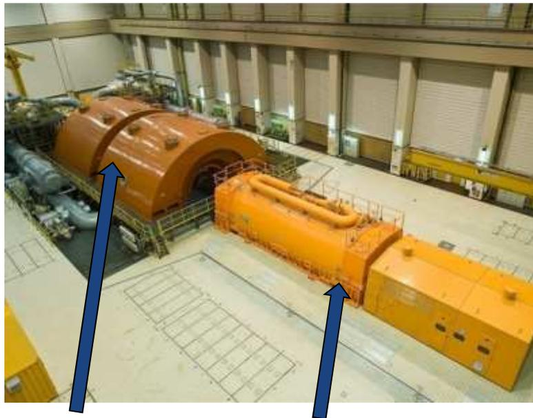
Dampfturbine mit Synchronmaschine
